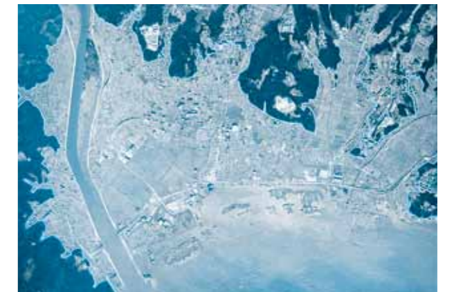
▼地震後(平成23年3月13日)
