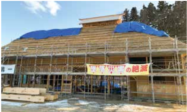
県指定有形文化財である旧吉田家住宅主屋の復旧を進めます
