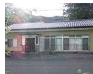
屋根を改修した清水公民館(矢作町)
