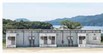
3.11 仮設住宅体験館
