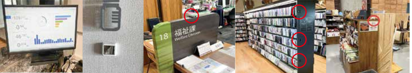
赤枠の箇所にセンサーを設置しています
