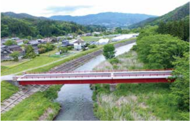
補修工事を実施した林道味米線の「味米橋」
