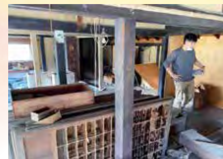
空き家調査の様子
