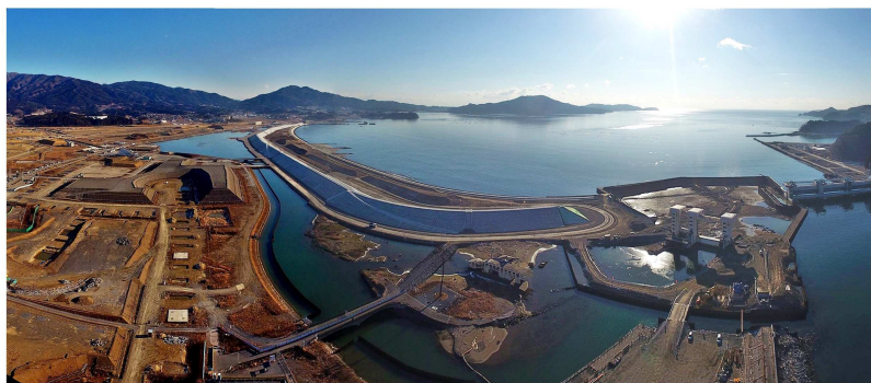
高田松原復旧工事状況（H29.1月）
