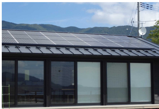
住宅用太陽光発電システム
