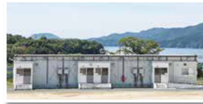
3.11 仮設住宅体験館
