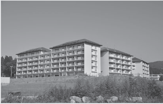
市営住宅下和野団地入居開始 (H26.10.1)
