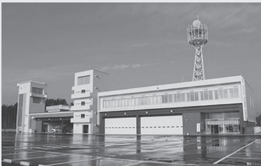
消防防災センター竣工式 (H26.11.23)
