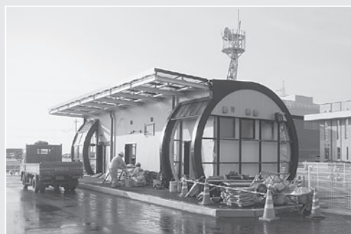
建設が進む新「陸前高田駅」（平成27年2月）
