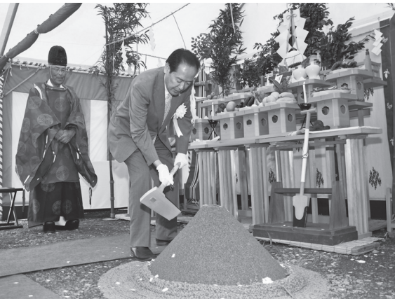
工事の安全を願いくわ入れや玉串奉てんなどが行われました
