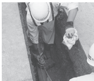
排水管布設工事
