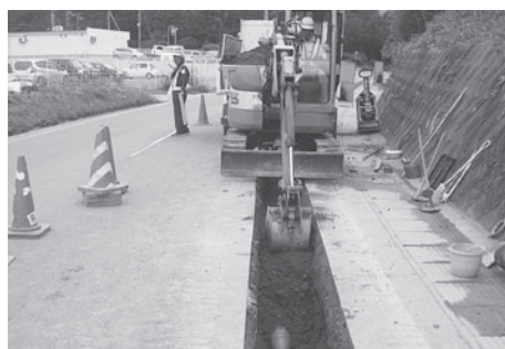
高台へ進む排水管
