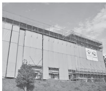
C 建設中の校舎
