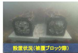
設置状況(根固方塊上)
