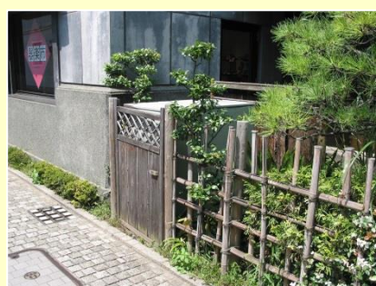
地上機器の民地引込み（川越市）
