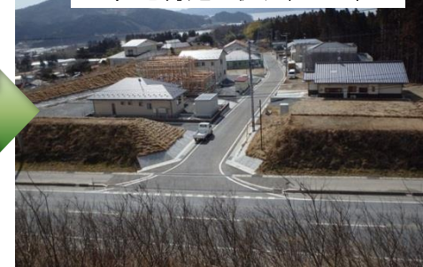
住宅再建の状況(H27.3)
