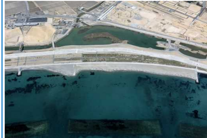
本格施工完成後（H31.4）
