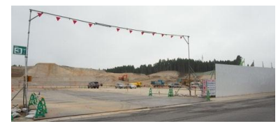
造成が進む橋ヶ沢地区建設予定地
