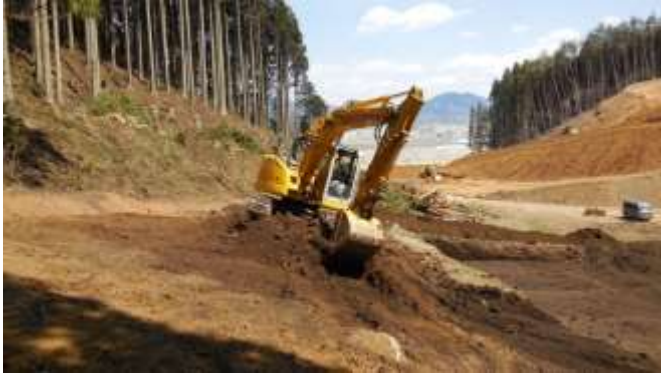
写真 2：重機による掘削作業状況
