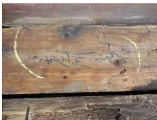
写真 7：確認された墨書跡
