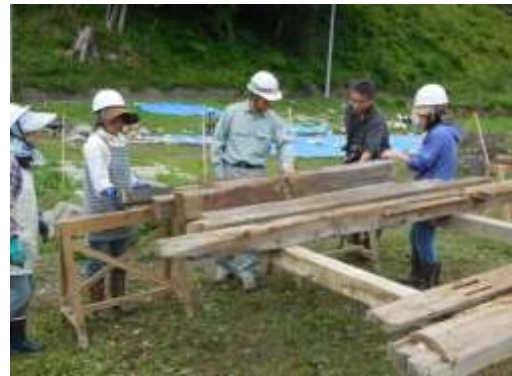
写真 4：破損状況確認調査
