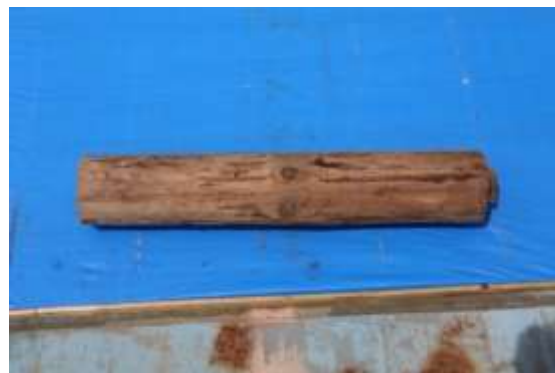
写真 10：比較的破損が少なかった部材
