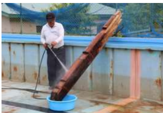
写真 11：高圧洗浄で表面の汚れを除去
