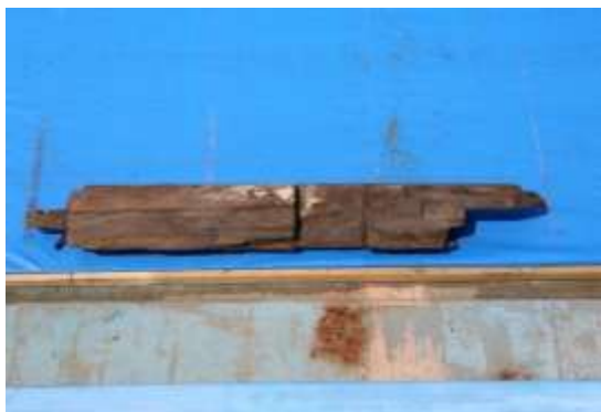
写真 9：激しく破損した部材
