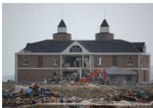
図 2 被災後の海と貝のミュージアム
