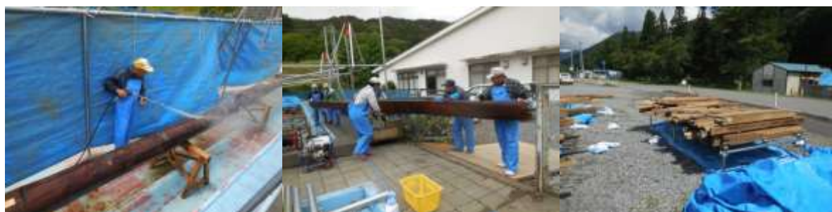
回収部材の高圧洗浄作業
