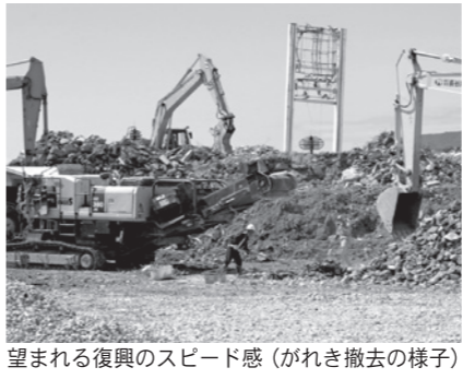
望まれる復興のスピード感（がれき撤去の様子）
