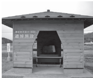
建設中の仮設追悼施設 (タピック前)
