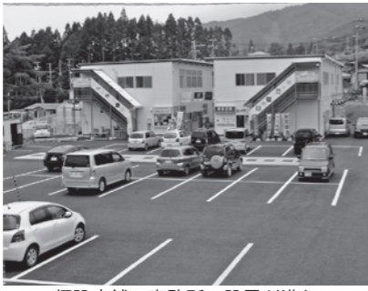
仮設店舗・事務所の設置が進む
