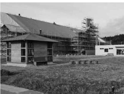
震災追悼施設等整備予定地 (高田町)
