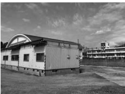
整備が進む防災・減災体験施設
