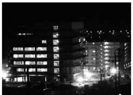
工事中の新庁舎と下和野市営住宅
