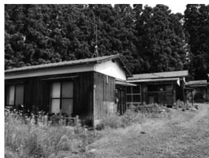
用途廃止・解体予定の市営住宅
