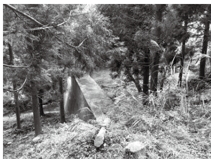
治山ダム（竹駒町滝の里）
