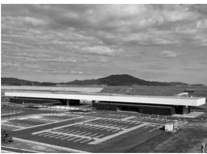
新設された道の駅
