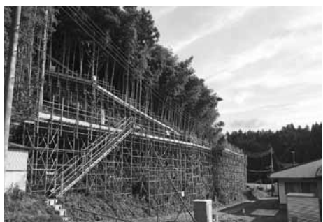
急傾斜対策施工中の様子
