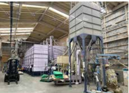
増設が求められる乾燥・貯蔵施設
