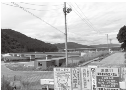
工事中の誂石橋
