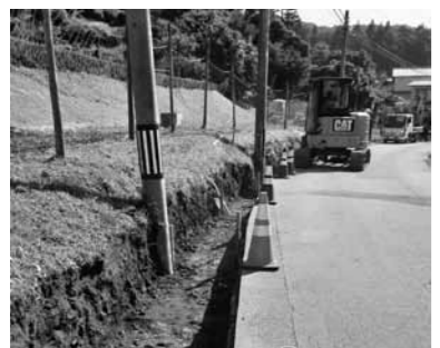
通学路の工事（市道柳沢和方線）
