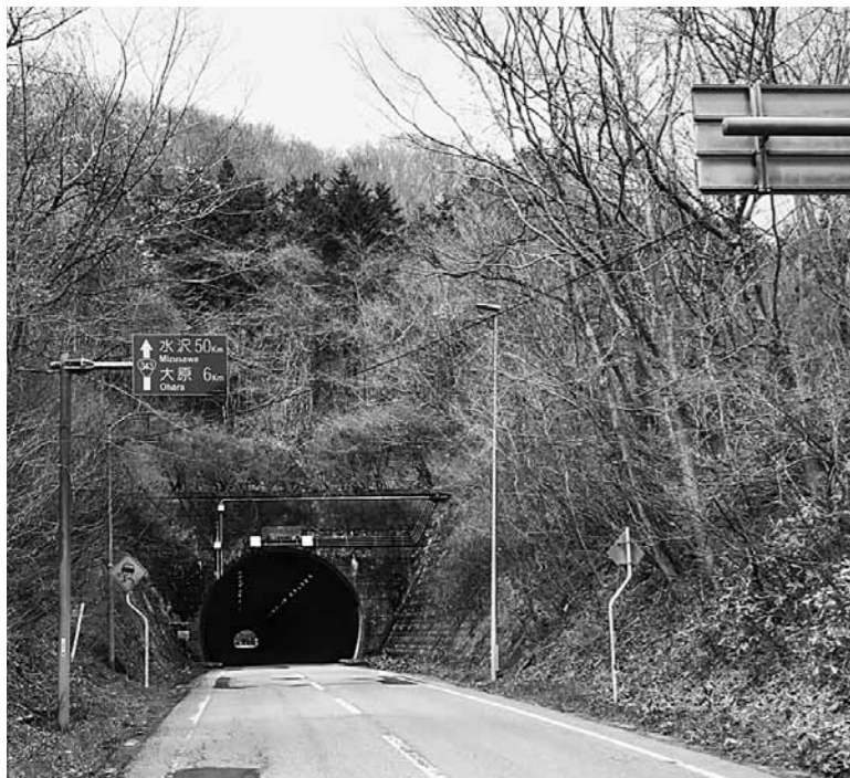
国道 343 号の笹ノ田トンネル
