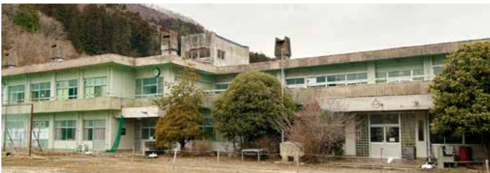
解体予定の旧矢作小学校
