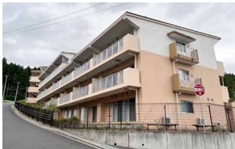
市営住宅（気仙町）
