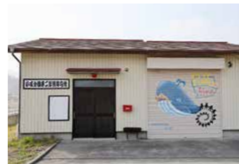
エアコンが設置される既存消防屯所
