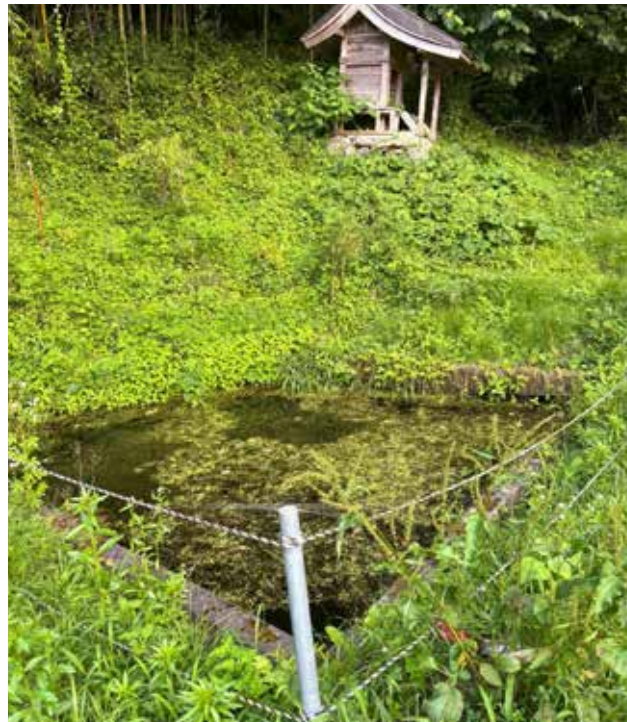
撤去予定の防火水槽（横田町）
