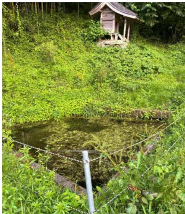
撤去予定の防火水槽（横田町）
