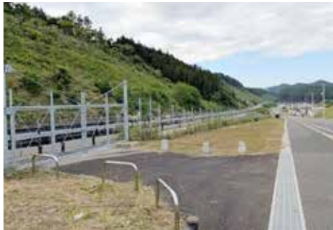
今泉地区にある緊急連絡路
