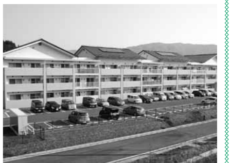
恒久住宅（今泉災害公営住宅）
