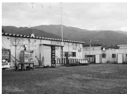
滝の里工業団地内の仮設住宅
