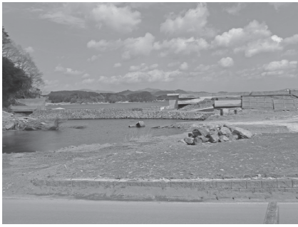
防潮堤 (広田町)
