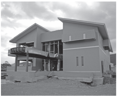
浄化センター
