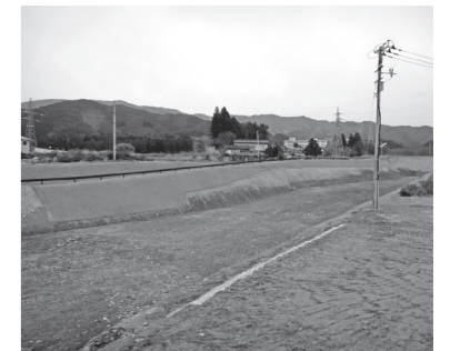
三陸縦貫自動車道工事現場 (高田町)
