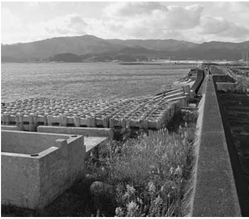
復旧工事が進む米崎町の脇之沢漁港
