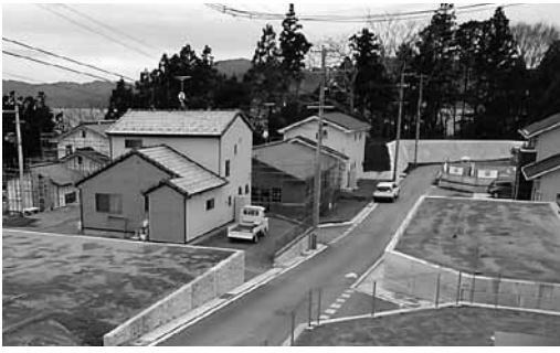
住宅再建が進む高台の団地（広田町）
