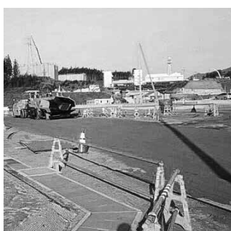
完成間近の高台2造成地
