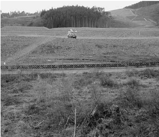
復興交付金事業により高台造成、かさ上げの進む今泉地区
