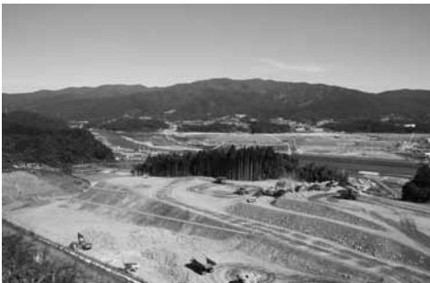
工事が進む今泉地区区画整理事業
