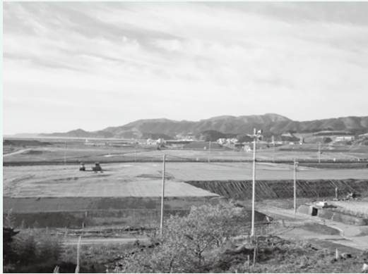
今年7月から大型商業施設整備が始まるかさ上げ地
