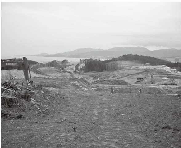
高田地区の高台5、6の造成工事
