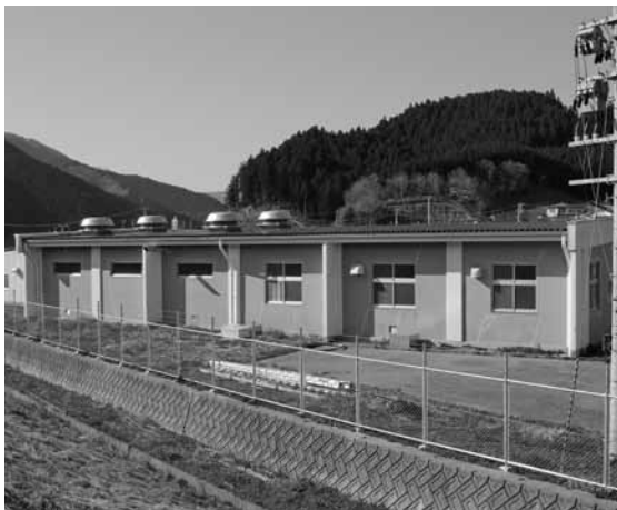
震災後に防水対策が講じられた竹駒第一水源
