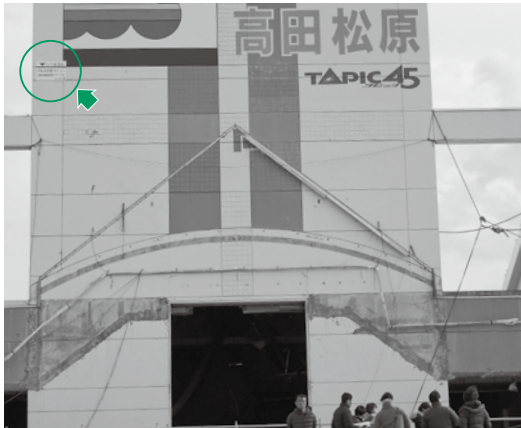
浸水高の標識がある旧タピック45
