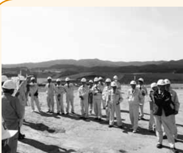
かさ上げ工事現場を視察
