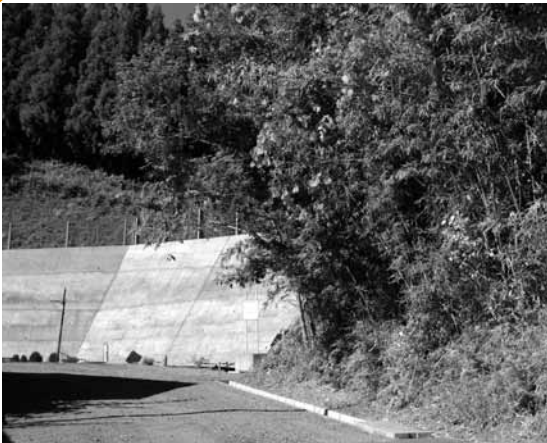
途中までとなっている急傾斜地の対策工事
