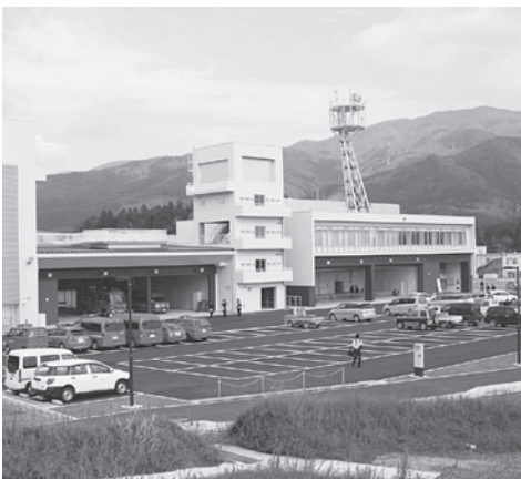
無線鉄塔が設置されている消防防災センター
