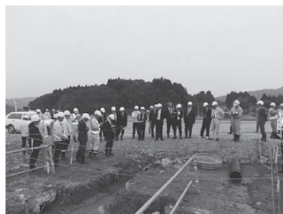
かさ上げ盛土工事前の現場を調査
