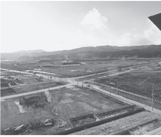
工事が進む中心商店街予定地
