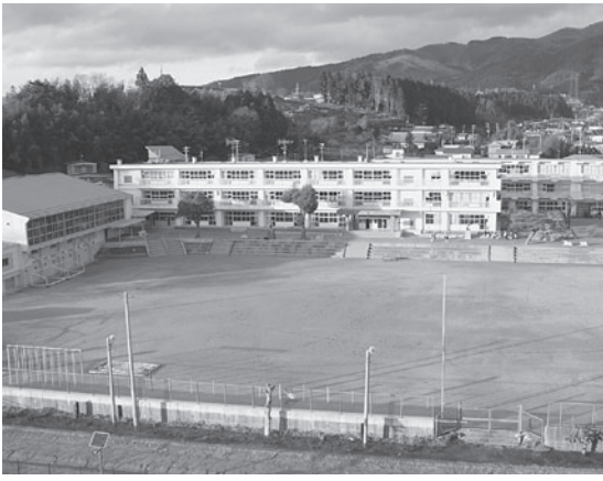
移転再建される高田小学校校舎
