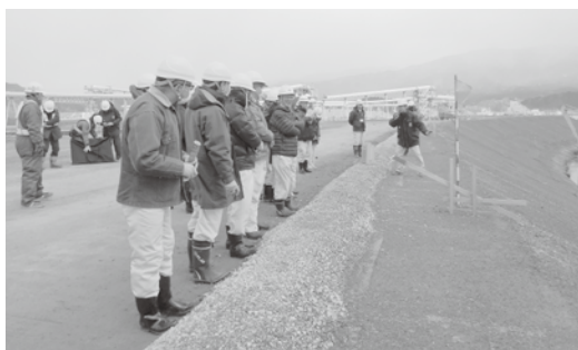
高田海岸防潮堤の工事現場を調査
