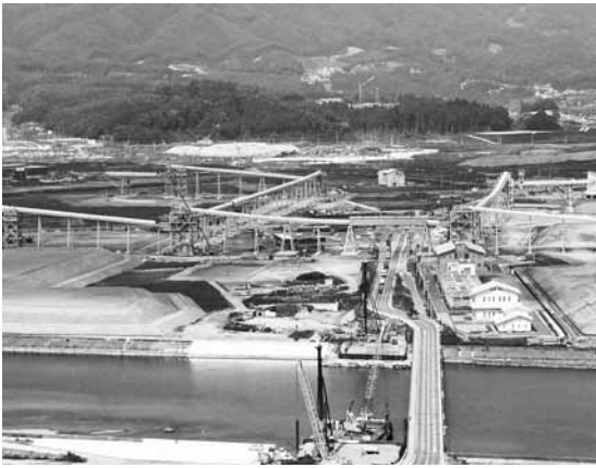
土砂搬送中のベルトコンベヤ
